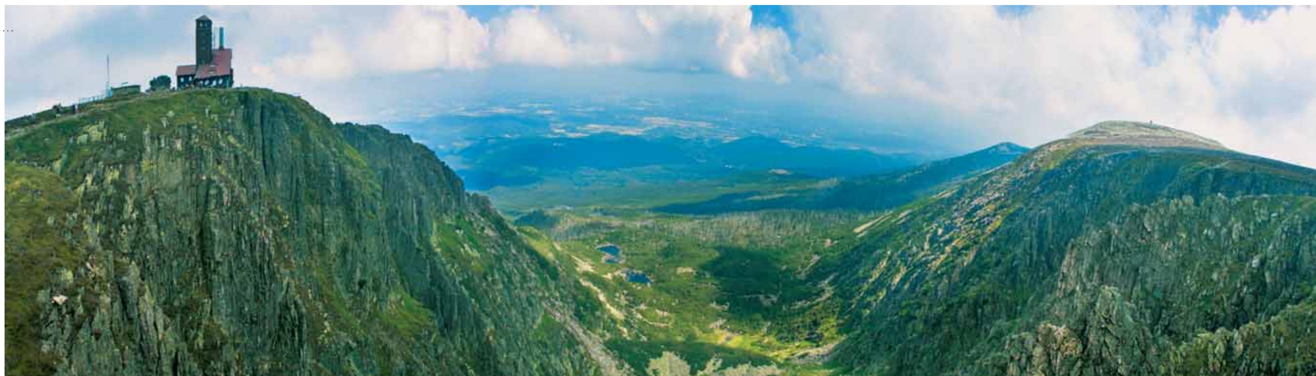
Nad Śnieżnymi Kotłami góruje budynek Centrum Nadawczego RTV, będący niegdyś schroniskiem
